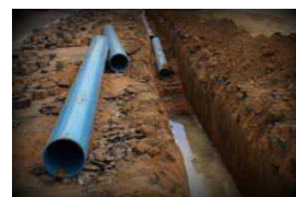
Exemplo de colocação de infraestruturas enterradas
